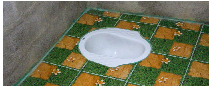
ตำแหน่งของส้วมต่ำกว่าปกติให้เหมาะกับการใช้งาน
