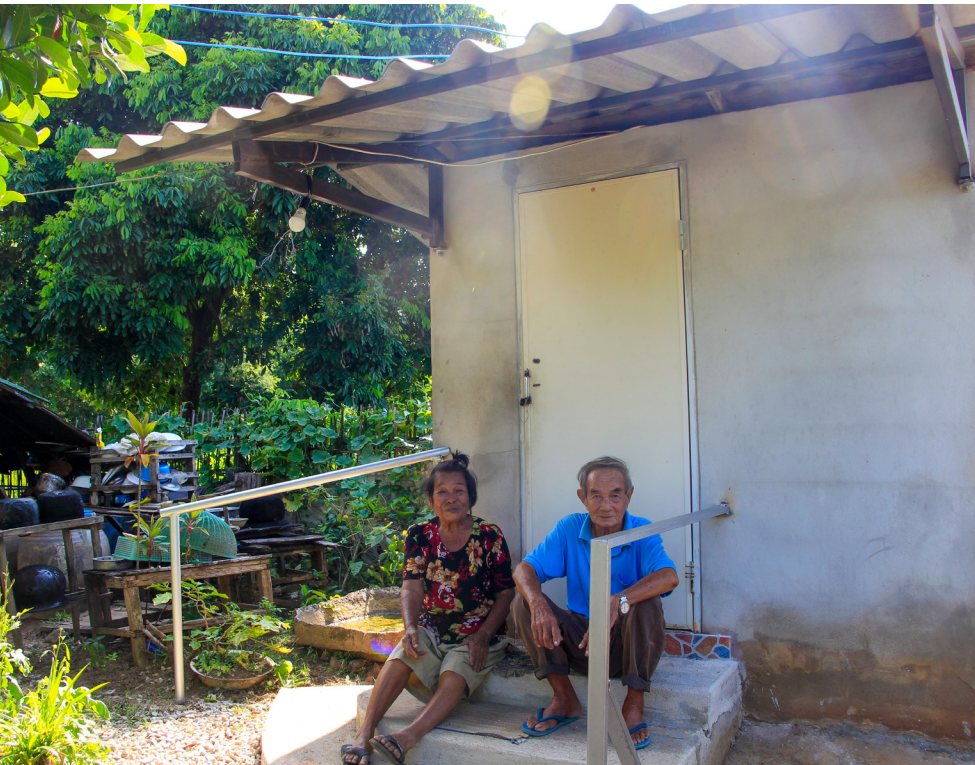
การปรับห้องน้ำให้มีบันได ราวจับ และชักโครก ทำให้คุณตากับคุณยายสะดวกมากขึ้น
